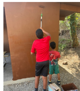
Abbildung 4 streichen des Pavillons
